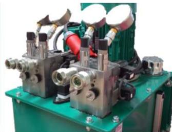
▪ Kundenspezifisches Aggregat mit BIERI-Pumpe und anwendungsspezifischen Ventilblöcken
