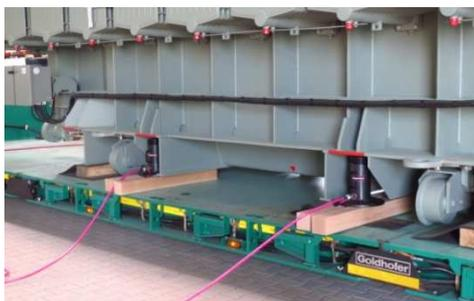
▪ Last wird mit vier gleichlaufenden Zylindern angehoben und zum Verschieben auf Rollen abgelassen
